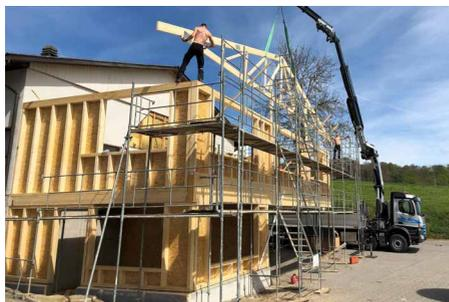
Pour cette exécution, nous avons opté pour une ossature entièrement bois avec revêtement de façade en panneau stratifié « Compact » et intérieur en doublage de panneau aggloméré décoratif. La charpente de toiture est, elle, composée de huit fermes triangulées avec portée de 15 mètres sans appui, recouvertes de plaques minérales ondulées.
